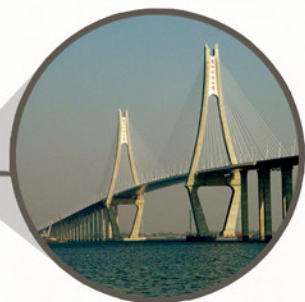
汕头海湾大桥
